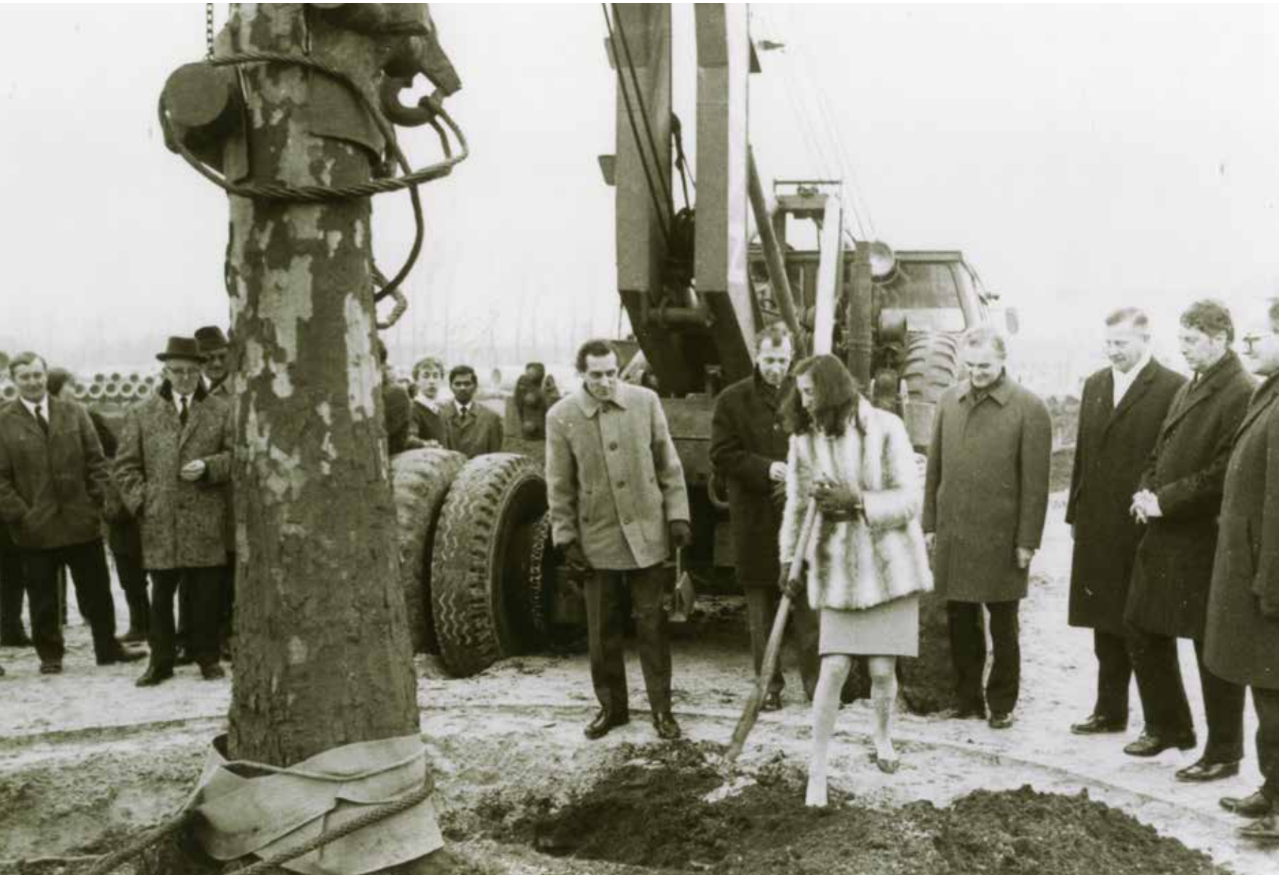
Met het planten van een boom op 24 maart 1970 gaat de bouw officieel van start.
