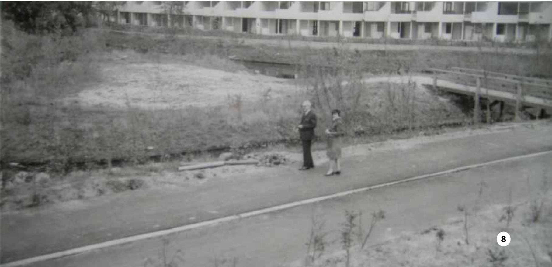
Aanleg speeleiland met brug.
